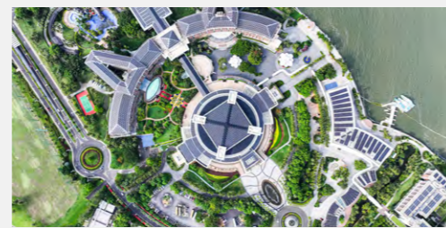
博鳌近零碳示范区光伏屋顶
