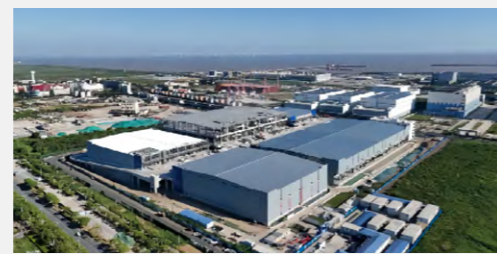
上海临港零碳物流园
