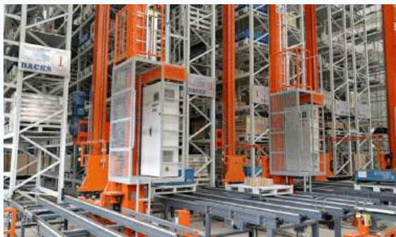
智能仓储系统配备 3168 个托盘位与 120 米 / 时的高速堆垛机
